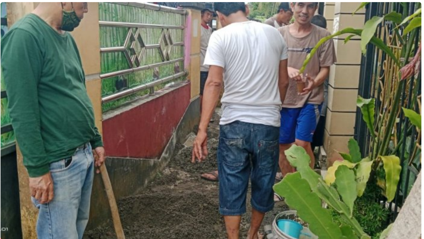
Jalan Gang Dibangun Secara Gotong di Sukabumi Jawa Barat
