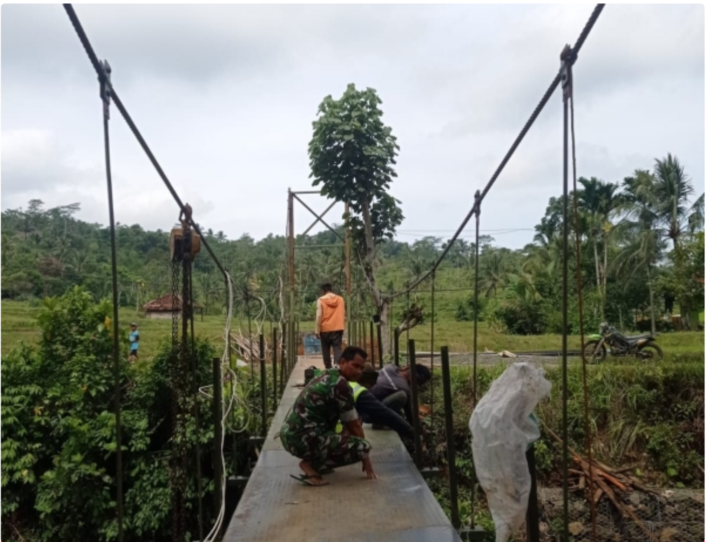
Kpt Arm Witono: Pengerjaan Jembatan Gantung Sudah 80%
